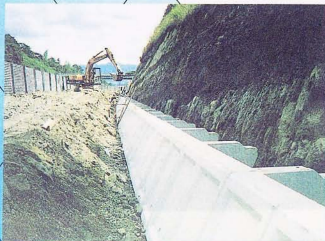
一段目施工完了(前面)
