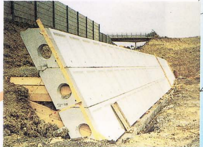
三段目施工完了
