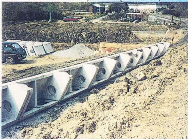
一段目施工完了(背面)
