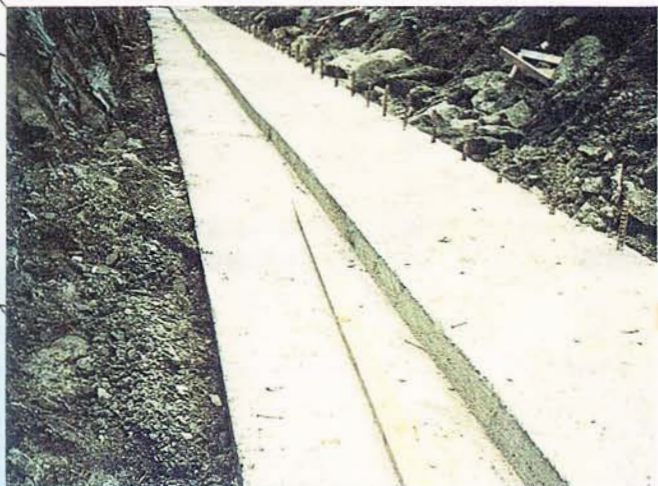
基礎施工完了
