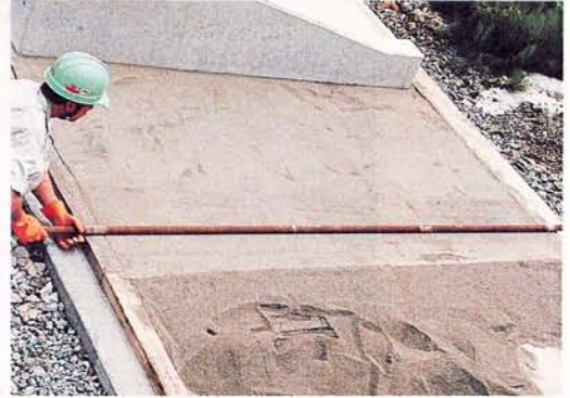
敷きモルタルの施工
